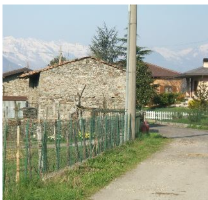
118. Un tratto di strada agricola
