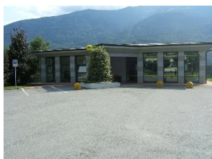
143. L'edificio che ospita il punto medico
