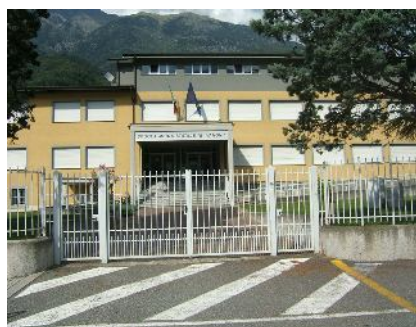
136. L'ingresso della scuola media Ezio Vanoni
