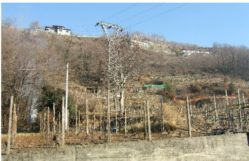
33. Un traliccio di sostegno dei cavi elettrici
