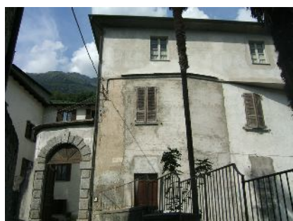
154. Il magnifico edificio storico che ospita l'oratorio
