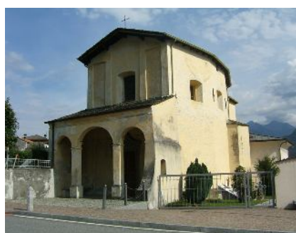
146. La Chiesa di S. Colombano nei pressi del cimitero
