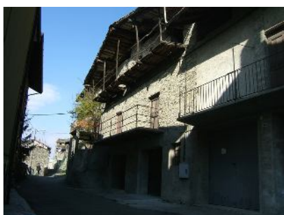
123. Piano terra di un edificio utilizzato come box per le auto
