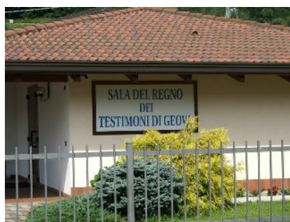
155. La facciata e l'ingresso della "Sala del Regno dei Testimoni di Geova"
